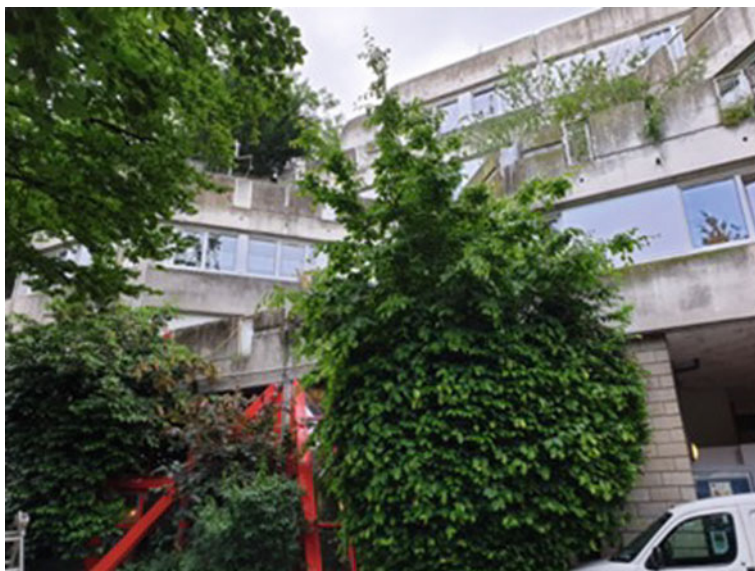
Fig. 7.5 Headquarter of the association Jardins à tous les étages (Gardens on all floors) in the Maladrerie
